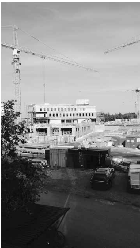
KTH キャンパスは、新しい校舎群の建設のため大規模な工事が行われていた
