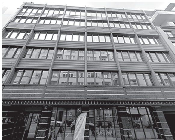
ENQAのオフィスが入る建物（出典：Google Earth）
